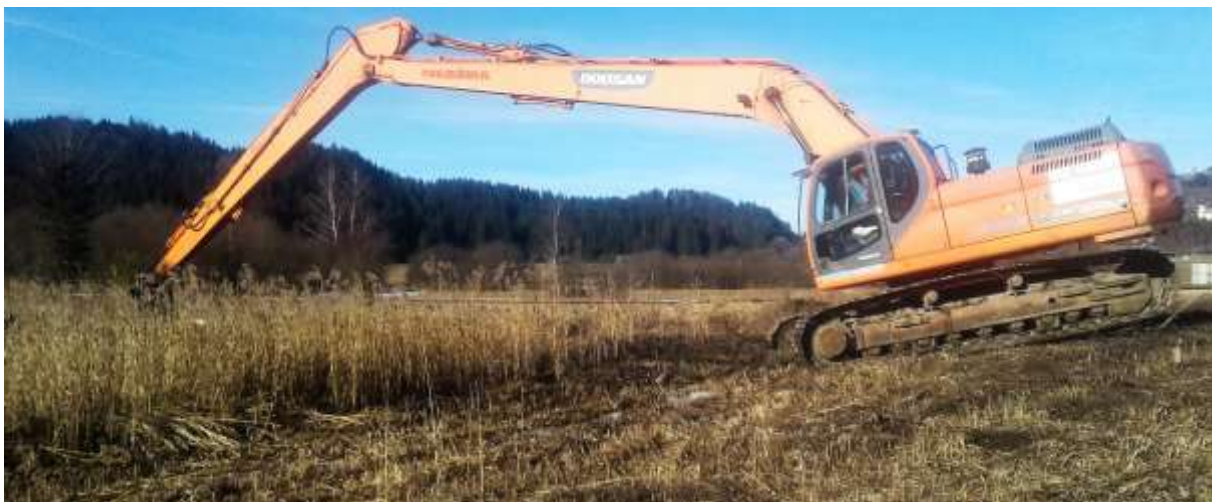
Abbildung 13: Als Ideal erwies sich der erstmalige Einsatz eines Longreach Baggers. Obwohl knapp 35 t schwer ermöglichen die breiteren Ketten und resultierend aus der großen Armlänge ein geringerer Druck und ein für die Verhältnisse hier rasches und effektives Arbeiten.
